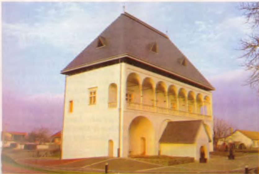
A Báthori Várkastély nem csak a hajdanvolt Báthoriak, hanem az épületet helyreállító Zombor család hírnevét is öregbíti
